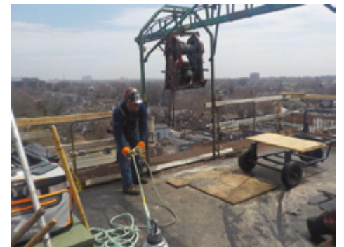
Sistemas de proteção contra quedas Créditos: Viana Roofing
