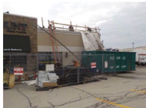
Local de trabalho resguardado e em segurança ao nível do chão - Créditos: Viana Roofing
